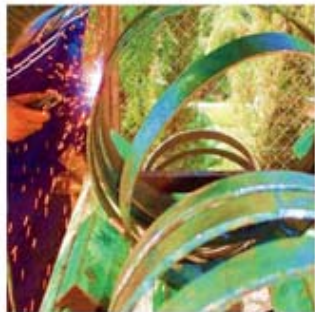
Orléans, 2017 (en proceso de construcción) Acero oxidado Altura máxima: 8 m
